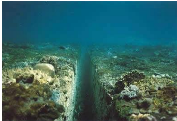
„Jetting” technology for cable protection
